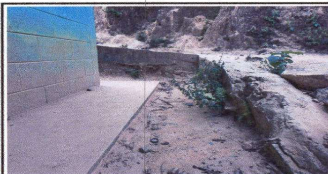
Foto 6: Reparación de muro perimetral block
