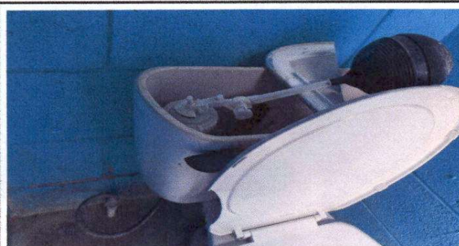
Foto 3: Sustrucción de accesorios inodoro (contra llave, tubo de abasto) + Sustrucción inodoro
