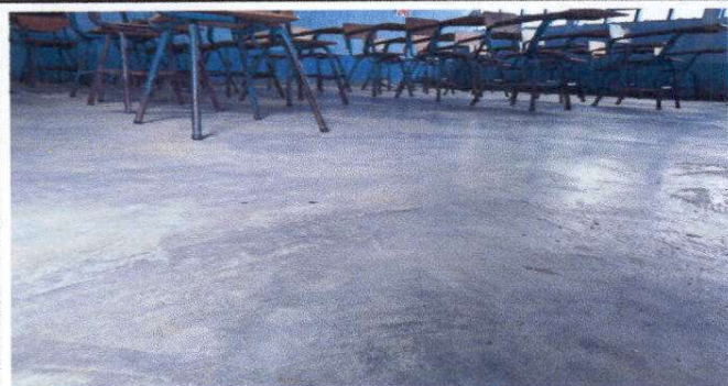
Foto 1: Sustrucción de piso de cemento líquido (por piso cerámico)
