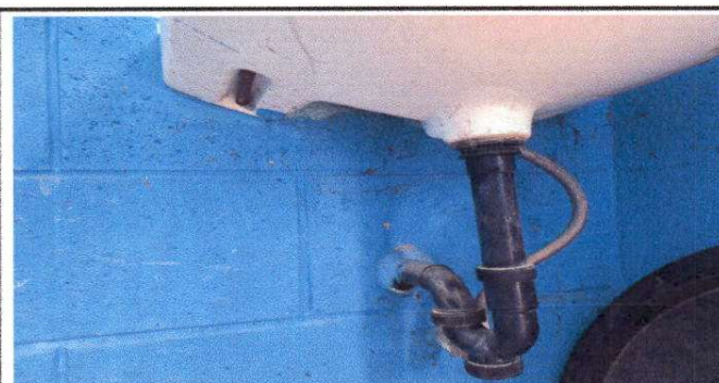
Foto 5: Sustrucción de tubería PVC línea principal aguas negras + Sustrucción de tubería lineal principal
