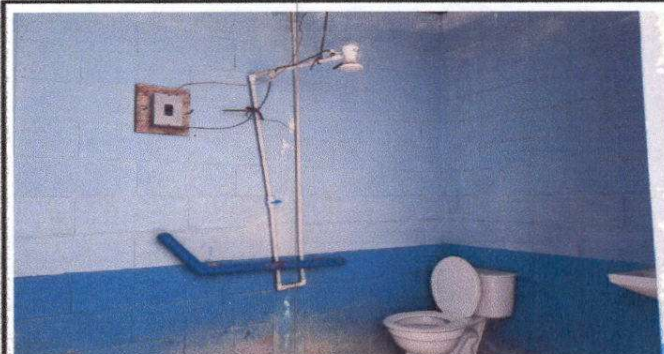
Foto 4: Sustrucción de mezcladora para ducha
