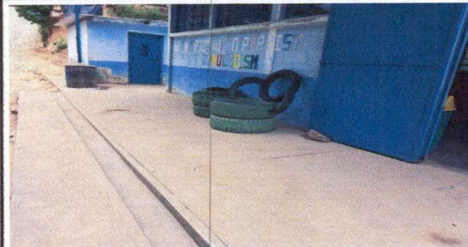
Foto 2: Pintura en muros exteriores e interiores
